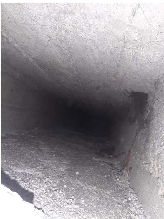
Obr. /č.11/ Sonda S03 – Mezi prostor železobetonového trámového stropu
