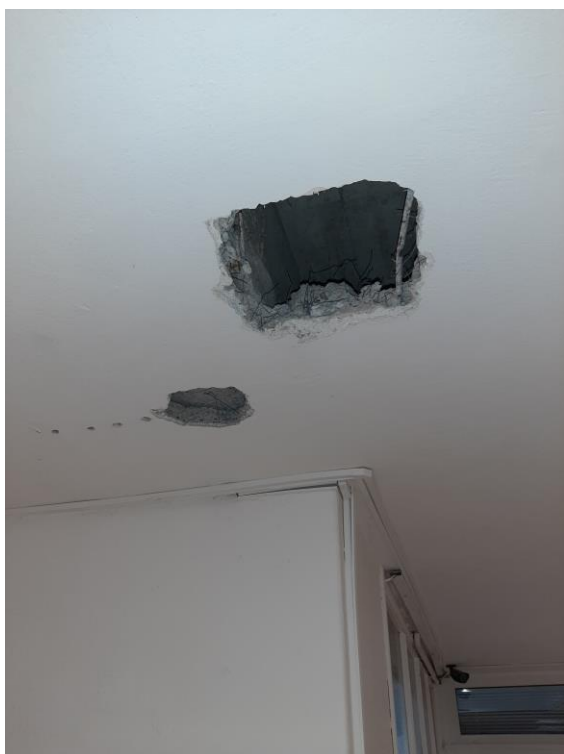
Obr. /č.8/ Pohled na provedenou sondu S03 – Strop haly, místnost č. 102
